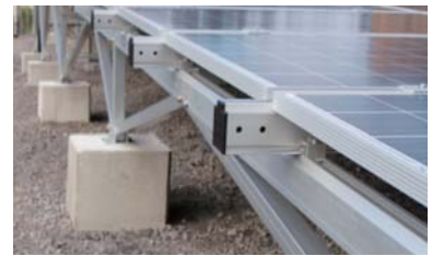
9 モジュール設置
