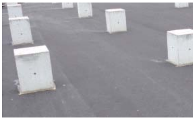
7 ブロック基礎設置
