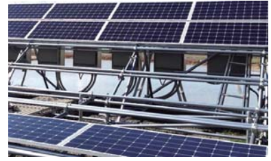
6 モジュール設置
